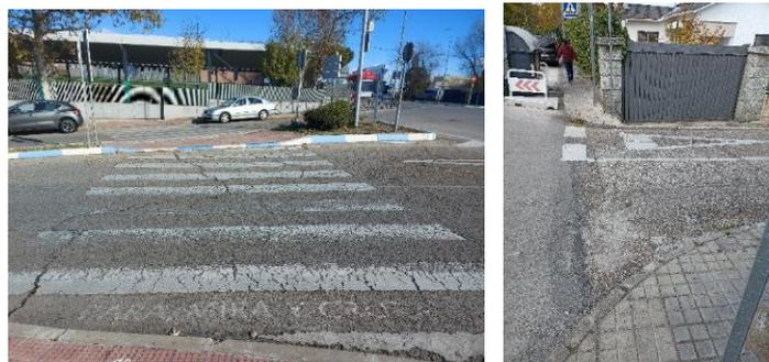
Ilustración 28 Ejemplos deterioro pavimento itinerarios peatonales
